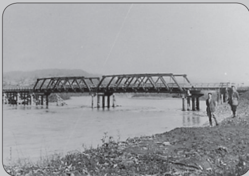
昭和 11 年頃の新冠大橋
