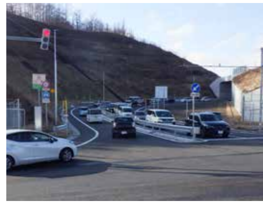
新冠インターチェンジ開通直後の様子
