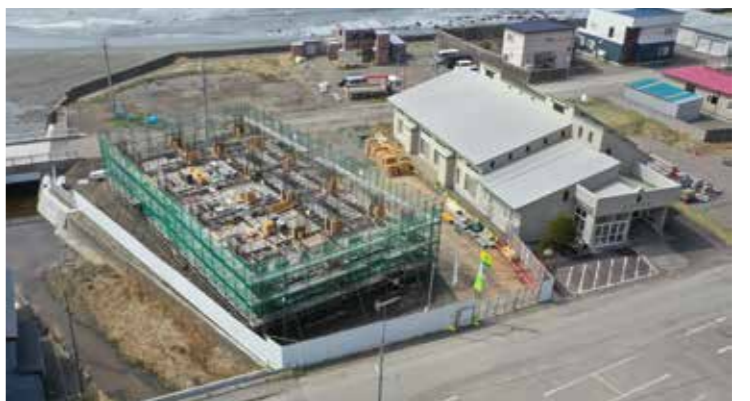
節婦生活館横に建設中の「津波避難タワー」
