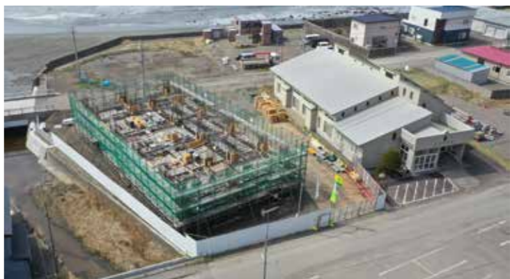
節婦生活館横に建設中の「津波避難タワー」
