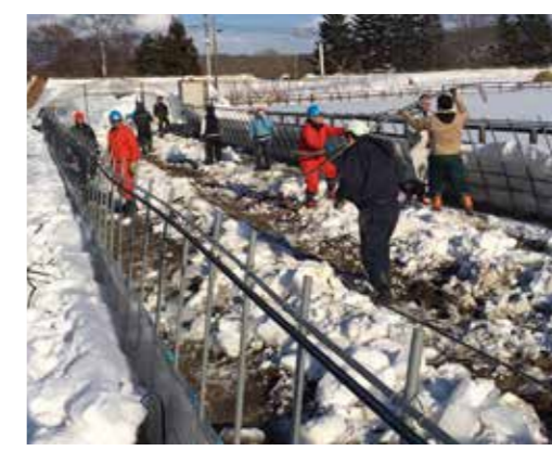
ビニールハウス撤去作業の様子
