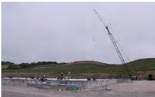
食肉センターの基礎工事
