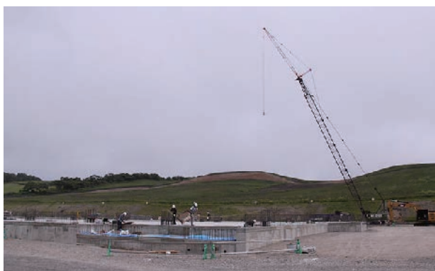
食肉センターの基礎工事
