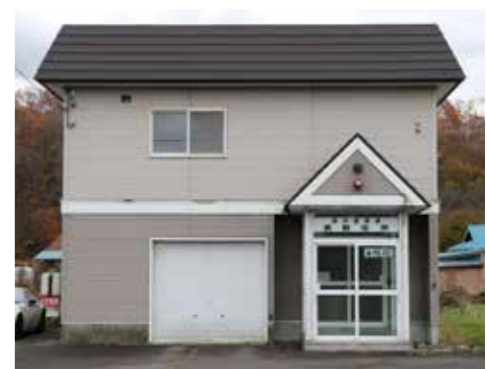
令和6年4月1日から廃止となる泉駐在所
