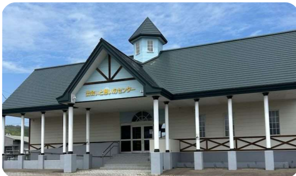
出会いと憩いのセンターの外観
