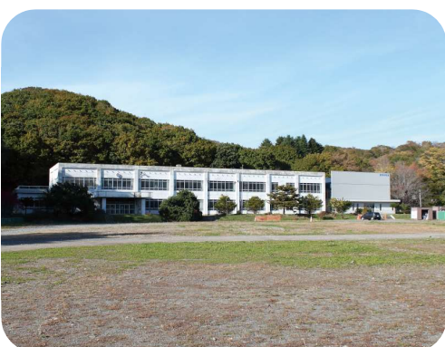
今後解体が検討される旧節婦小学校
