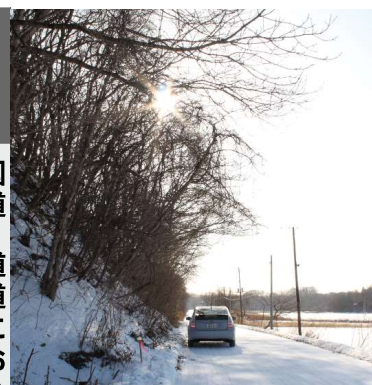
道路上に張り出す枝（町道）
