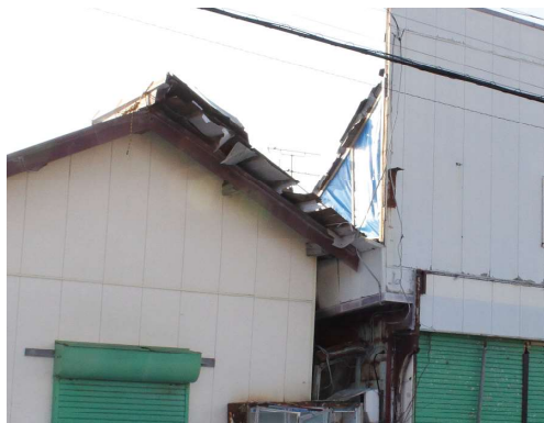
応急修繕した所有者不在の空き家
