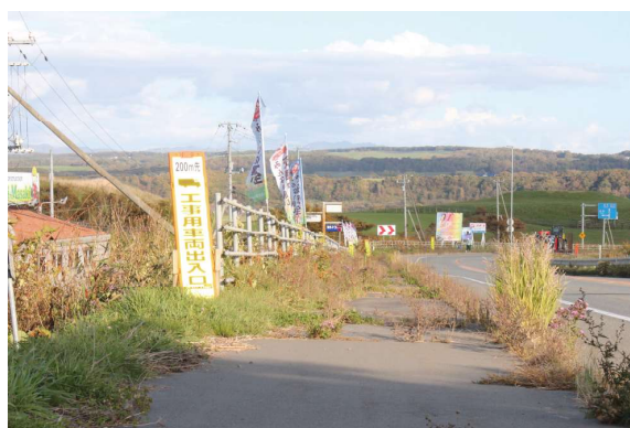
維持管理が不十分と感じられる道路敷地(国道)
