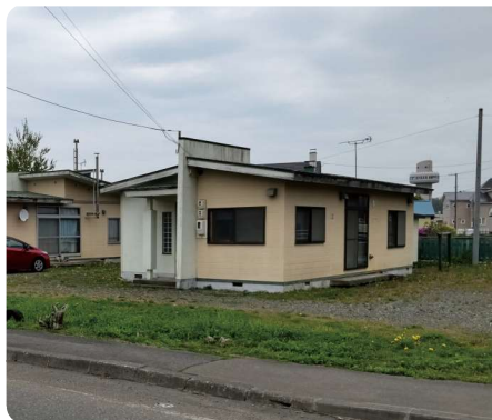
空き家の教職員住宅
