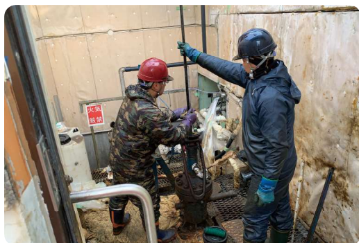
湯場装置点検工事現場
