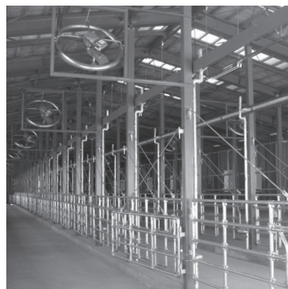
完成間近の新冠町和牛センター内
